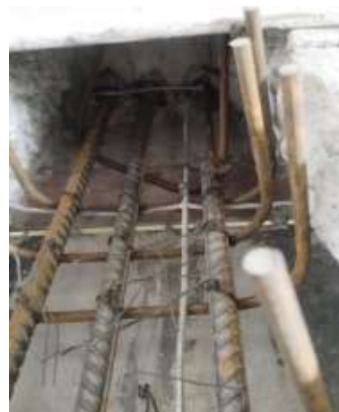
Fig. 20 Reinforcement of the cast-in-place beam. Photo by Dmytro Levkivskyi Рис.20 Армування монолітної балки. Автор фото Дмитро Левківський
