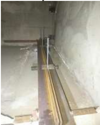
Fig. 8 Scheme for lifting and leveling the balcony slab Рис.8 Схема виважування плити балкону
