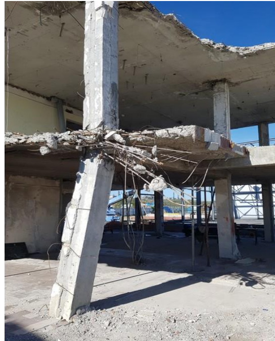
Fig. 5. Vertical deflections of concrete columns Рис. 5. Вертикальні переміщення колон
