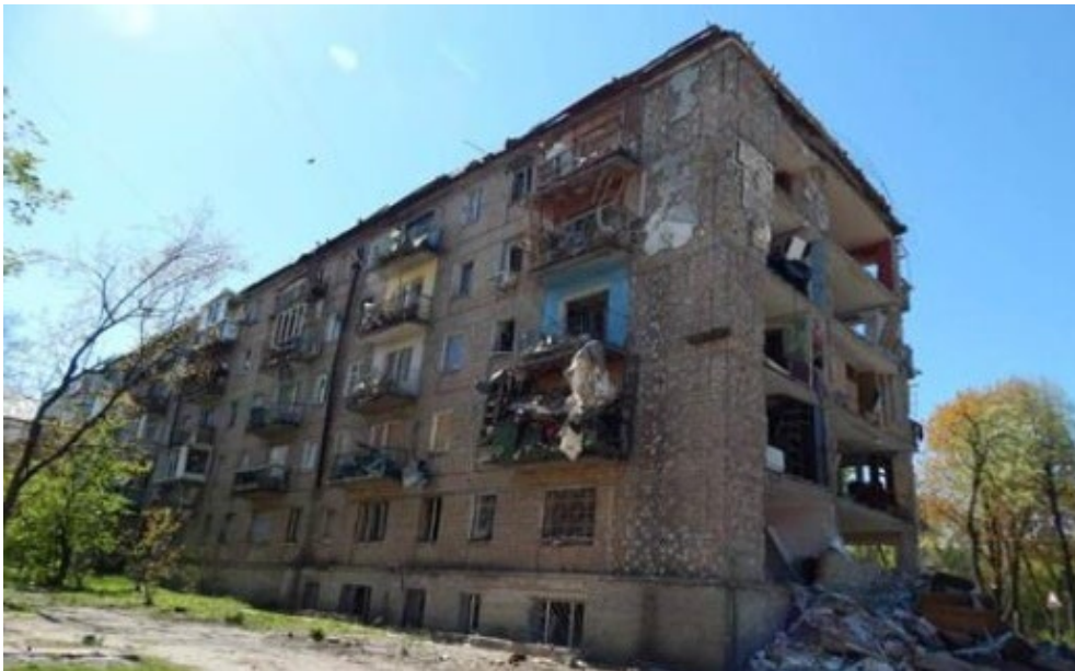
Рис. 1. Часткове обвалення п'ятиповерхового житлового будинку (1967 рік забудови) [3] Fig. 1. Partial collapse of a five-story residential building (built in 1967) [3]
