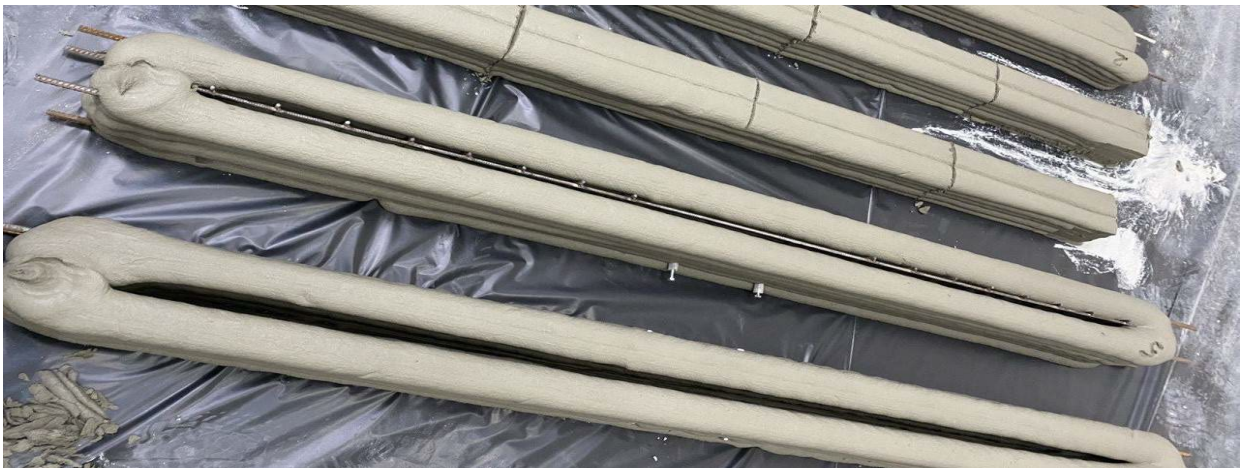
Рис. 7. Балка зі встановленим вертикальним арматурним каркасом Fig.7. Beam with installed vertical reinforcement cage
