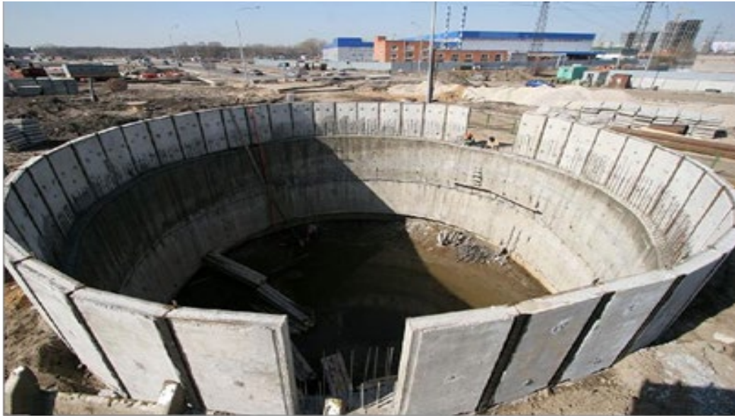
Рис. 2. Проходка збірно- монолітного опускного колодязя. Fig. 2. Passage of a prefabricated monolithic well.
