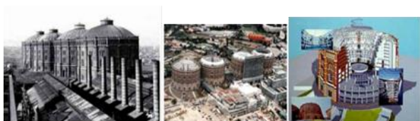
Fig. 1. Renovation of the gasholders in Vienna Рис.1. Ремонт газгольдерів у Відні
