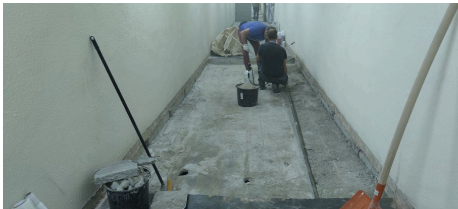
Рис.5. Демонтаж конструкції існуючої підлоги влаштованої по плитам.
