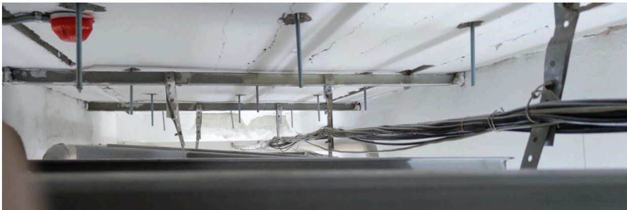
Рис.8. Влаштування елементів підтримки нижньої полицки існуючої плити.
