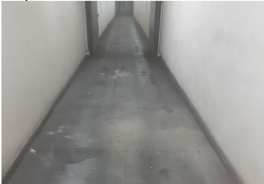
Рис.9. Відновлена підлога після підсилення плити перекриття. Fig.9. Restored floor after strengthening the floor slab.
