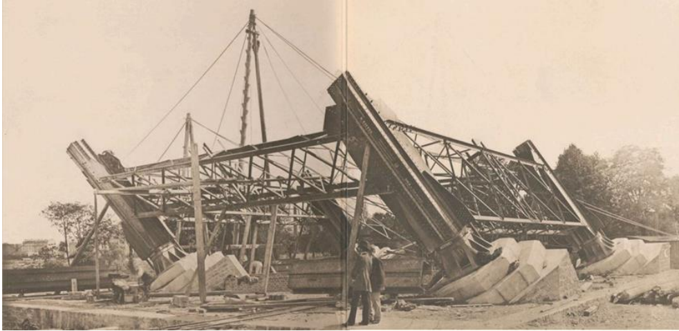
Рис.2. Опора №4 Ейфелевої вежі 18 липня 1887 року [2] Fig.2. Support No. 4 of the Eiffel Tower on July 18, 1887 [2]
