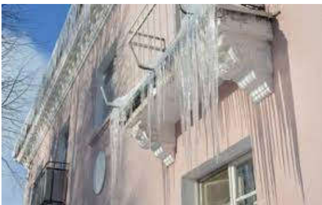
Рис.7. Навантаження на балконну плиту під час льодіння Fig.7. Anti-icing loading onto the balcony slab
