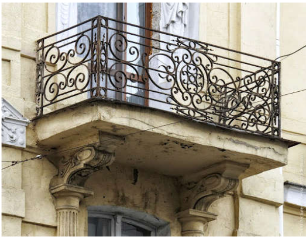
Рис.3. Балкон, влаштований з плити на залізобетонних балках (м. Одеса)
