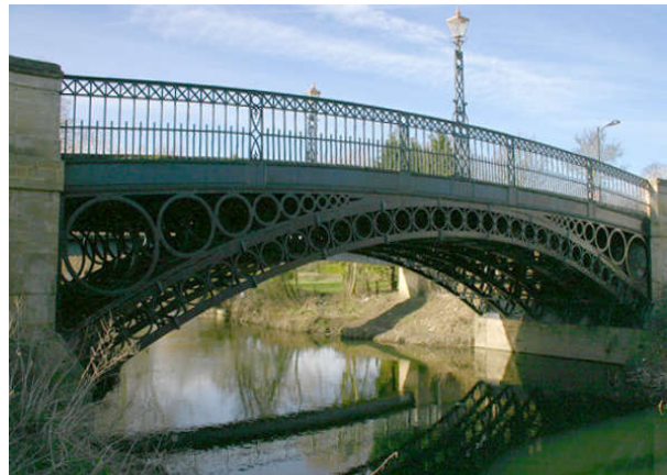
Рис.2. Тікфордський чавунний арочний міст в Великобританії. Fig.2. Tickford cast iron arch bridge in Great Britain..
