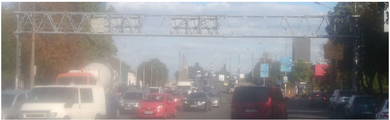
Рис.1 Сталева оцинкована рамна конструкція для автоматичних систем управління дорожнім рухом. Fig.1 Galvanized steel frame construction for automatic traffic control systems.
