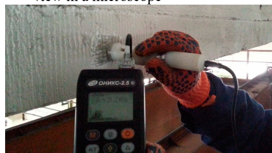
Рис.10. Визначення міцності бетону приладом «Онiкс-2,5» в балці покриття.
