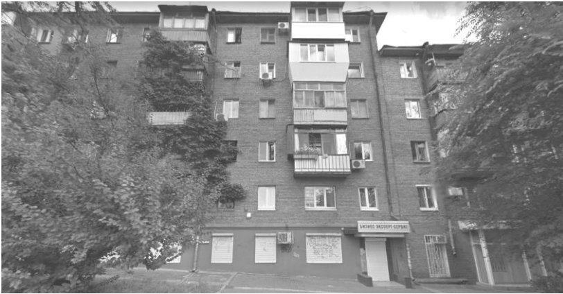
Рис. 2. Загальний вигляд існуючої будівлі, що досліджується
