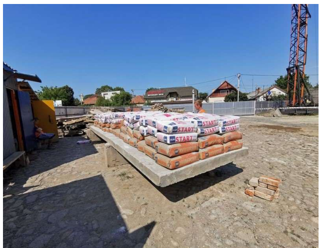
Рис.8. Черговий етап завантаження плити Fig.8. Another stage of loading the slab
