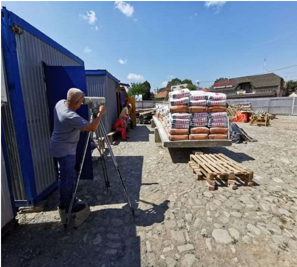
Рис.11. Вимірювання переміщень під час навантаження плити
