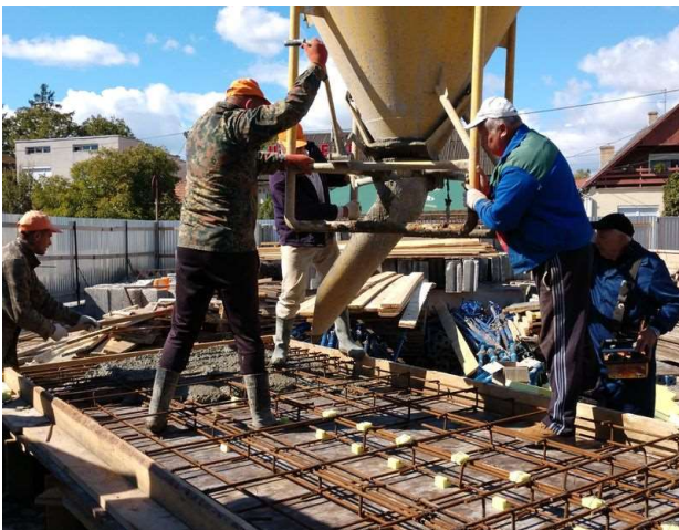
Рис.5. Бетонування багатопорожнистої плити Fig.5. Concreting of multi voided concrete slab
