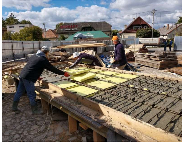
Рис.4. Встановлення порожниноутворювачів Fig.4. Adding voids to concrete slab, while concreting
