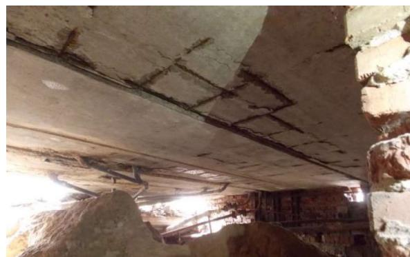
Рис.4. Пошкодження захисного шару бетону, огоління і корозія арматури, тріщини в плитах
