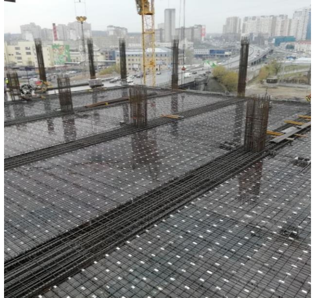
Рис. 3. Монолітне перекриття з попередньо напруженими балками та плитами в процесі будівництва (Будівництво торговельно-розважального комплексу в м. Києві)
