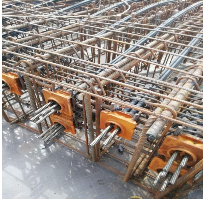
Рис. 7. Зона анкерування попередньо напружених канатів в монолітній залізобетонній балці (Будівництво торгівельно-розважального комплексу в м. Києві)
