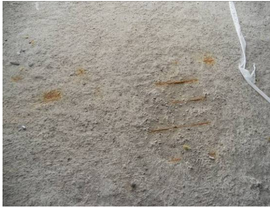
Рис.4. Руйнування захисного шару бетону, корозія арматури на верхній грані плити перекриття Fig. 4. Damage of the concrete cover and reinforcement corrosion on the upper side of the 8 th -floor slab
