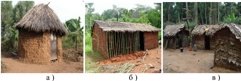
Рис. 1. Старовинні форми житлових будівель в Республіці Конго з місцевих матеріалів будівель, що зводились: а) будівля циліндрична з дерев'яним каркасом та огорожуючими стінами з глинистих блоків; б) будівля прямокутна з вертикальних і горизонтальних дерев'яних елементів; в) будівлі квадратні з використанням листя дерев при влаштуванні огорожуючих стін
