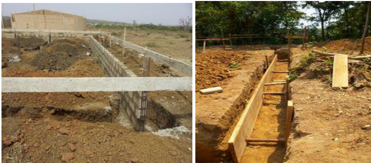
Рис.5. Влаштування опалубки при зведенні стрічкових фундаментів
