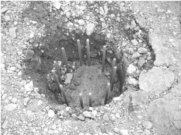
Рис.3. Зовнішній вигляд свердловини, щойно заповненої бетоном
